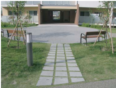
ピロティ： 地域の生活同線が団地のピロティを抜けて、接続した。
